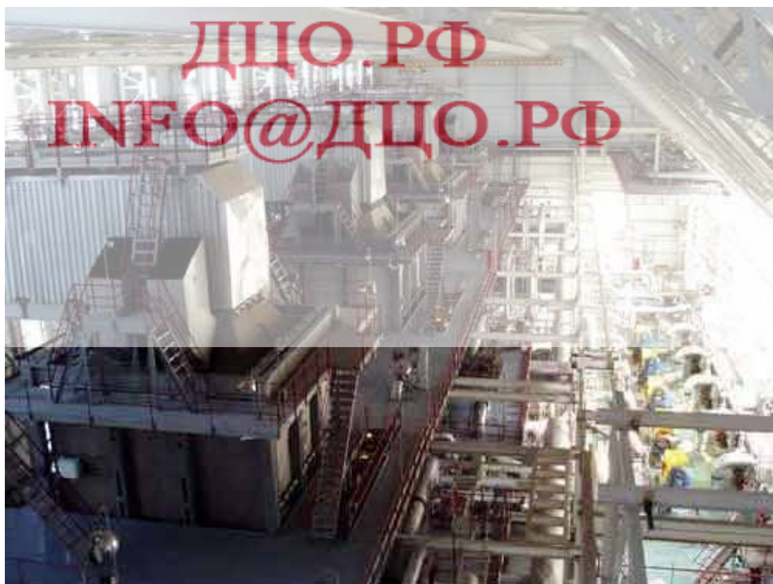
Рис. 2 – Водогрейный котел ПТВМ-100
