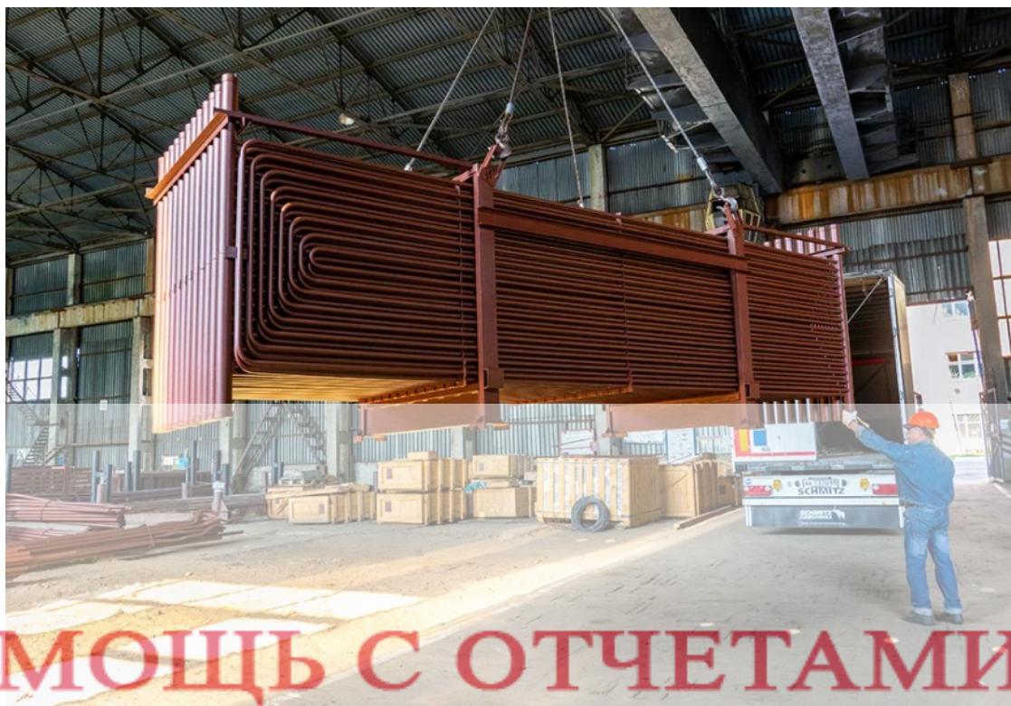
Рис. 4 – Конвективная часть котла типа ПТВМ-100 в состоянии монтажа
